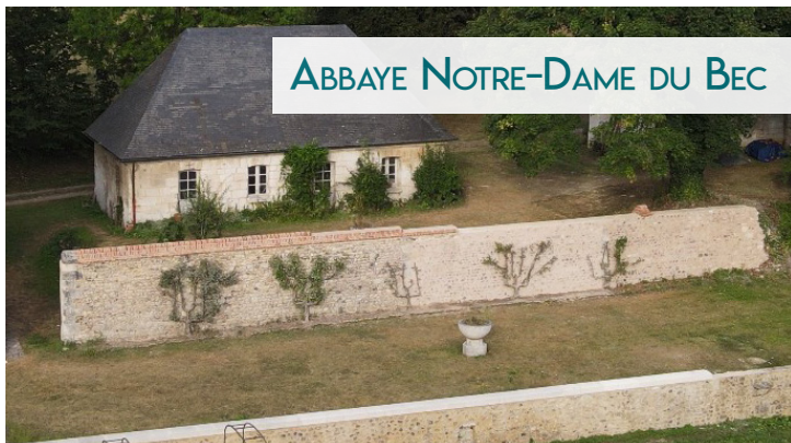
Murs de soutènement Abbaye Notre-Dame du Bec, Le Bec-Hellouin, 2025
